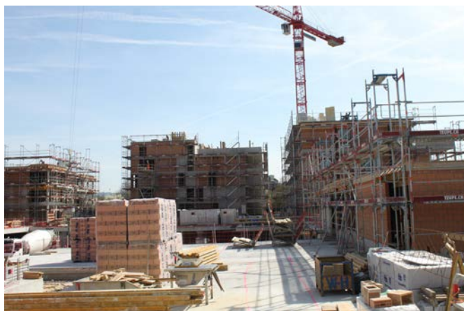
↓ Bild oben: Nach über zwei Jahren Projektentwicklungs- und Planungszeit konnte der Baustart im August 2016 beginnen. Bild unten: Die ganze Wohnüberbauung wird im Minergie-P Standard realisiert
